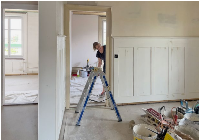
Cornelia Jungck legt in ihrem Umbauprojekt gerne auch selber Hand an, um die alte Bausubstanz zu spüren, wenn es die Zeit zulässt.
